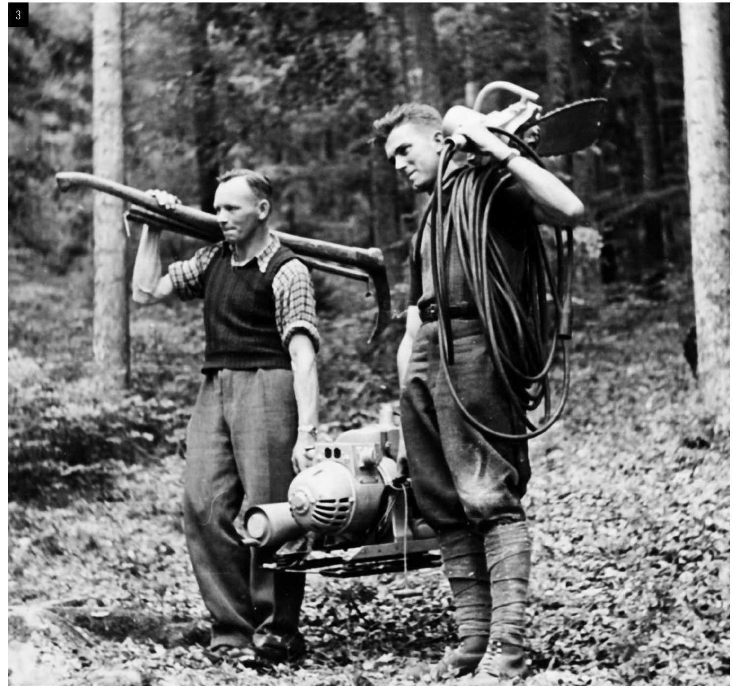
© «Datenbank historische Holzernte» des Fördervereins Forstmuseum Ballenberg 1. Zwei Arbeiter zersägen einen auf dem Boden liegenden Baumstamm mit einer Zweimann-Gestellsäge, die auf Zug und Druck arbeitet. Aufgrund der Grösse der Säge können sie in aufrechter Haltung arbeiten. 2. Drei Männer begutachten eine geschärfte Axt. 3. Zwei Männer tragen die komplette Ausrüstung mit Generator und Säge zum Arbeitsort im Wald zu einem Demokurs.
