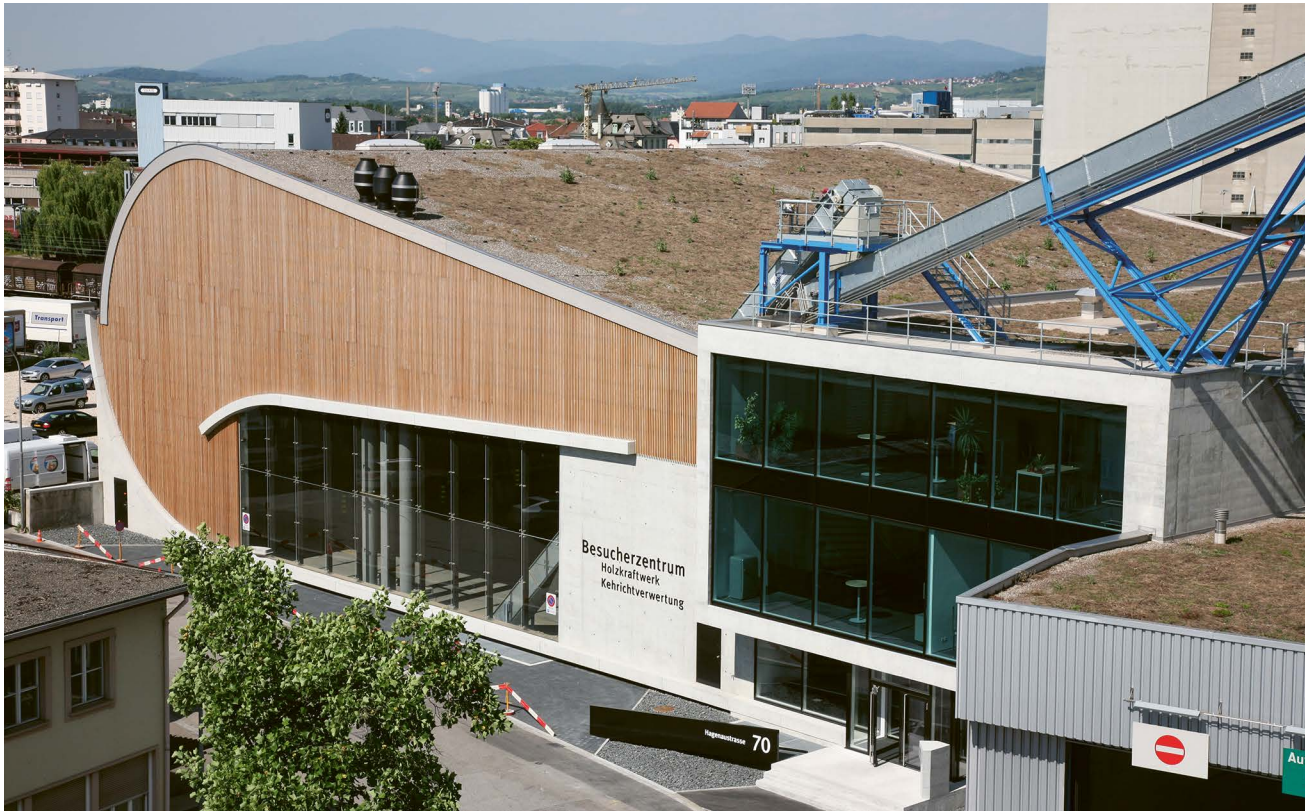
| 11 | Im Holzkraftwerk Basel wird nicht nur Holz aus der Nordwestschweiz in Energie umgewandelt. Die Fassade der Aufstockung des Holzkraftwerks Basel besteht aus einem Fachwerk aus regionalem Buchen-Stabschichtholz von Fagus Suisse.
